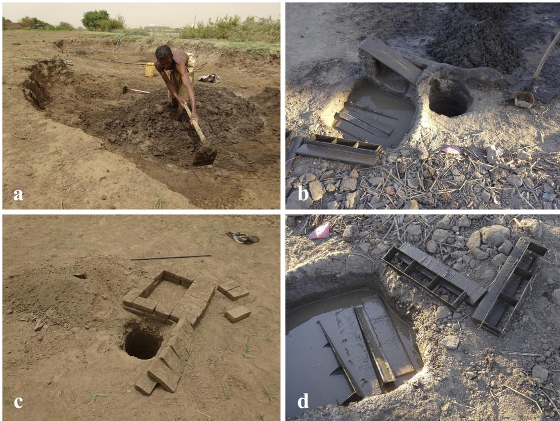
**Figure 2. Processus de fabrication des briques**
